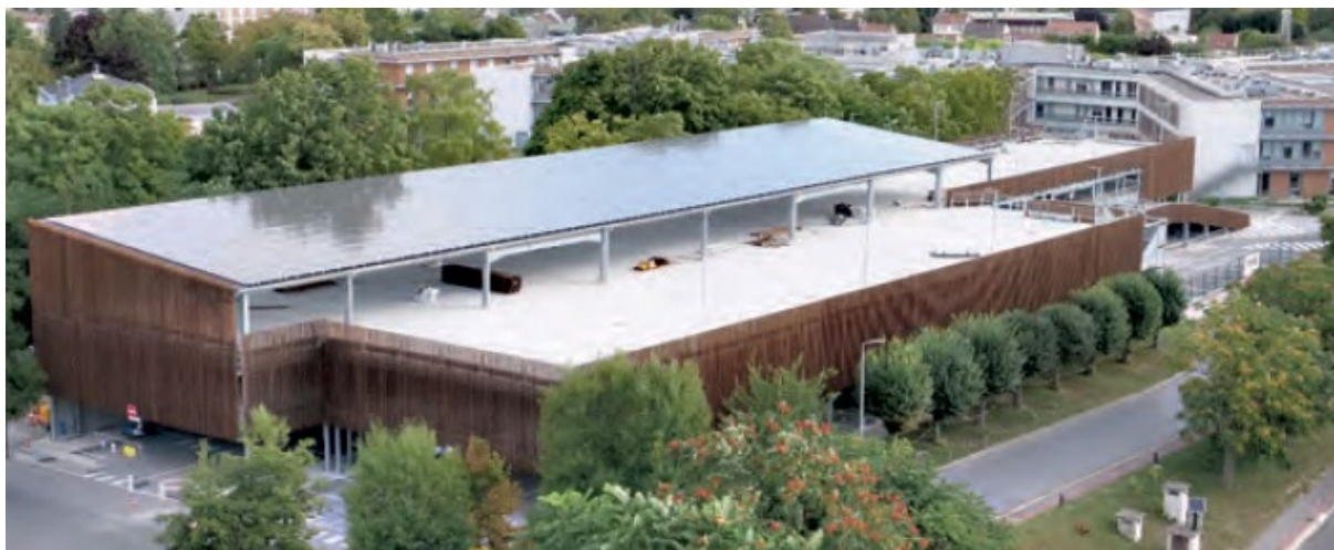
Parking modulaire équipé de panneaux photovoltaïques
